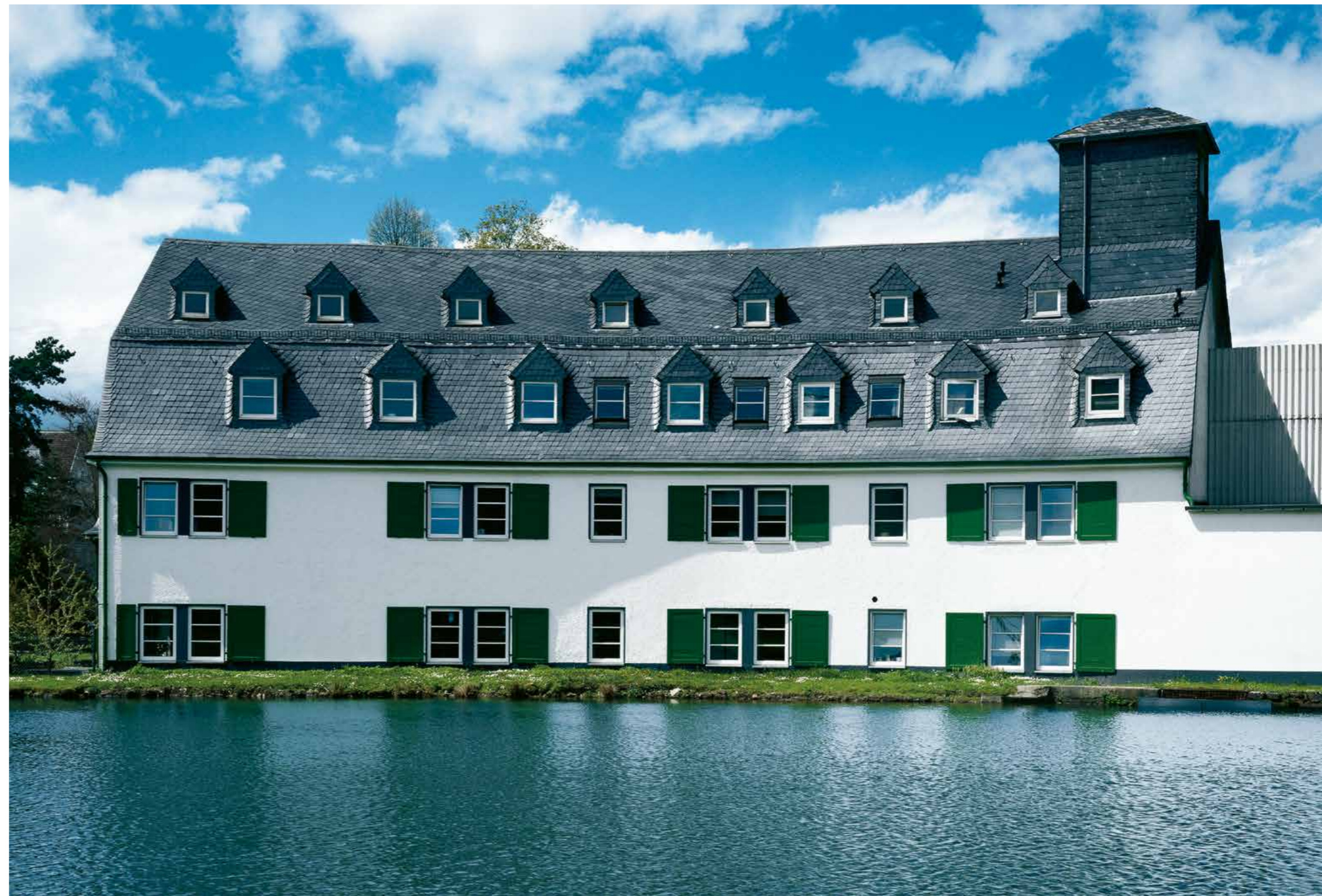
Das traditionsreiche Verwaltungsgebäude der Firma Jokey-Plastik erhielt für sein Mansarddach PRIMERO-Bogenschnittschablonen (Foto entstand 15 Jahre nach der Dacheindeckung - ein Beweis für Beständigkeit).
