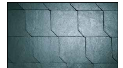
Wabe - von links nach rechts einge- deckt (umgekehrte Deckrichtung ebenso möglich)
