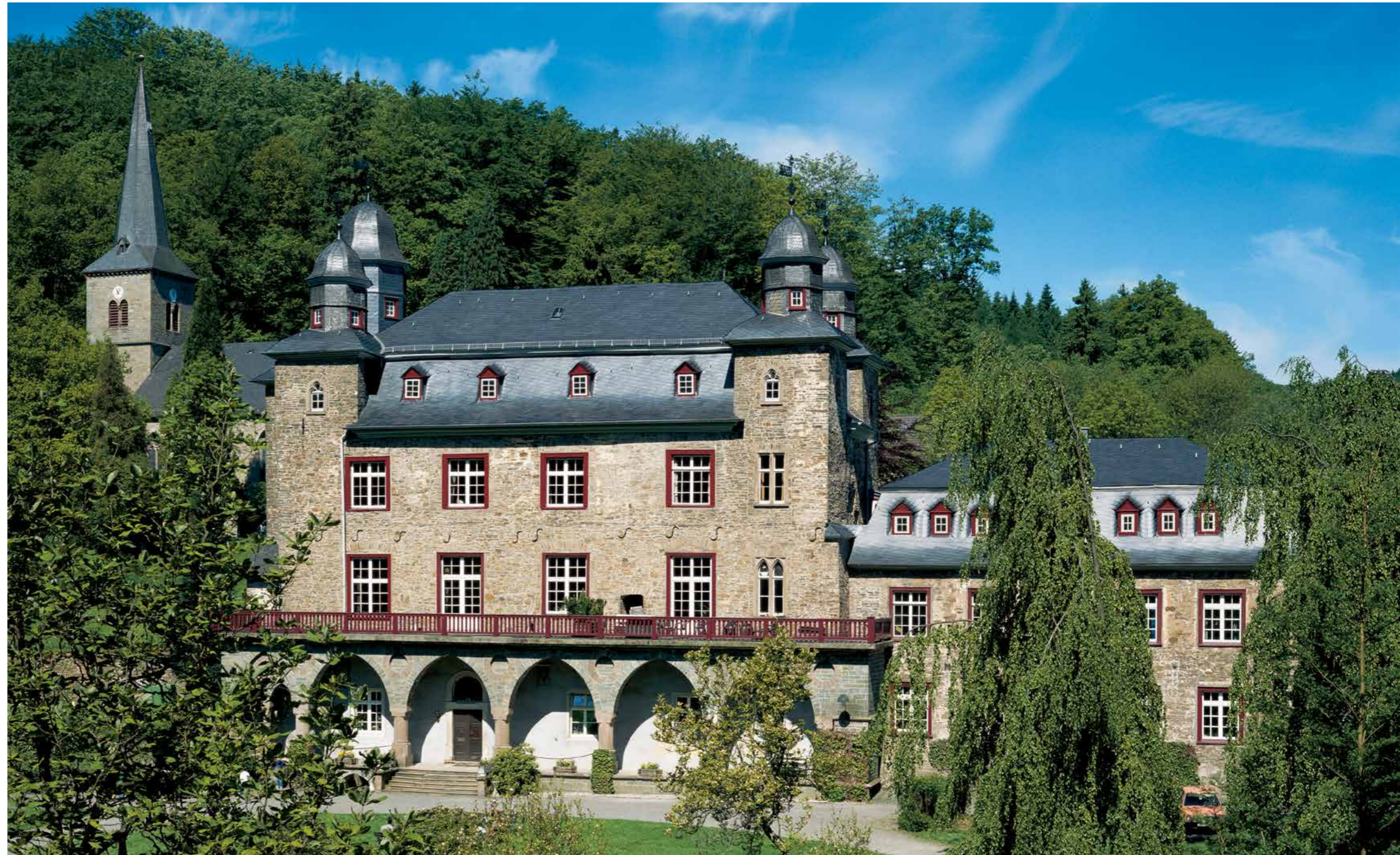
Neuer Glanz für Schloss Gimborn nach erfolgreicher Dachsanierung mit PRIMERO-SCHIEFER.
